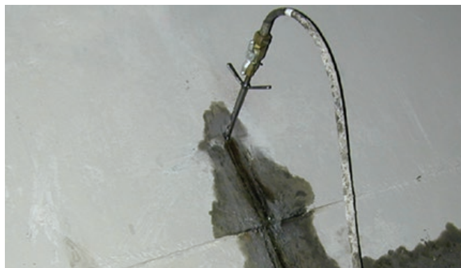
Foto 2: Risanamento di fessure mediante CarboCrackSeal NV
